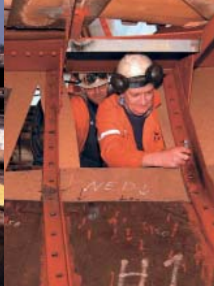
Jan Klipper tegner en mal for den nye plata han skal lage og montere.
